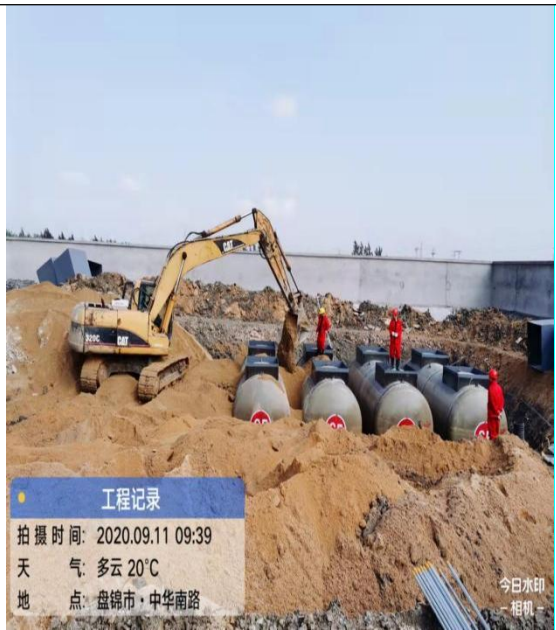
SF 双层储罐
