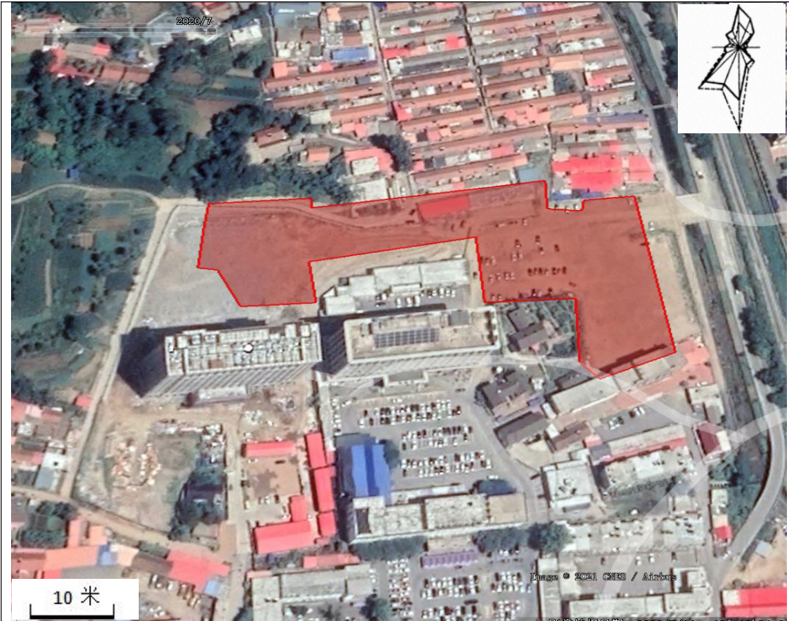
2020年7月（地块内西侧区域进行土地平整）
