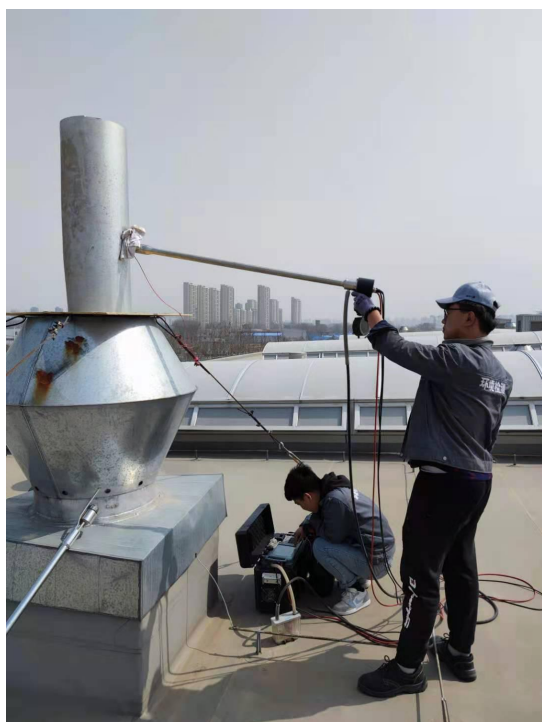
热处理淬火水槽排口 (FQ8)
