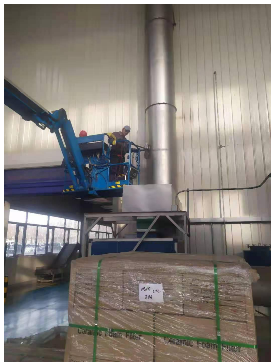
熔化炉除尘排口（FQ2）
